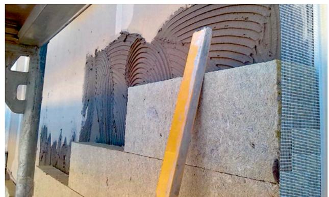
5 | Überprüfung der Verklebung mit Angabe des Bauteils und der Lage z. B. Achse 2
