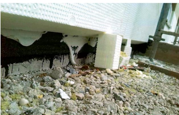
2 | Abgeschrägte Perimeterplatte verklebt auf Sockelabdichtung.
