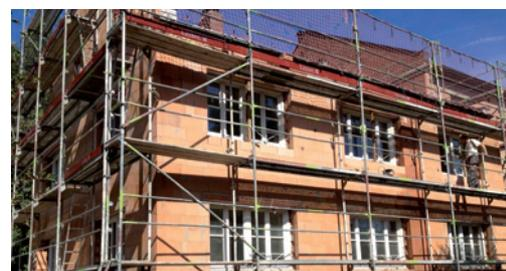
Mit Poroton-WDF in d=120 mm wurde ohne weitere vorherige Maßnahmen in nur wenigen Tagen die Fassade gedämmt und erneuert.
