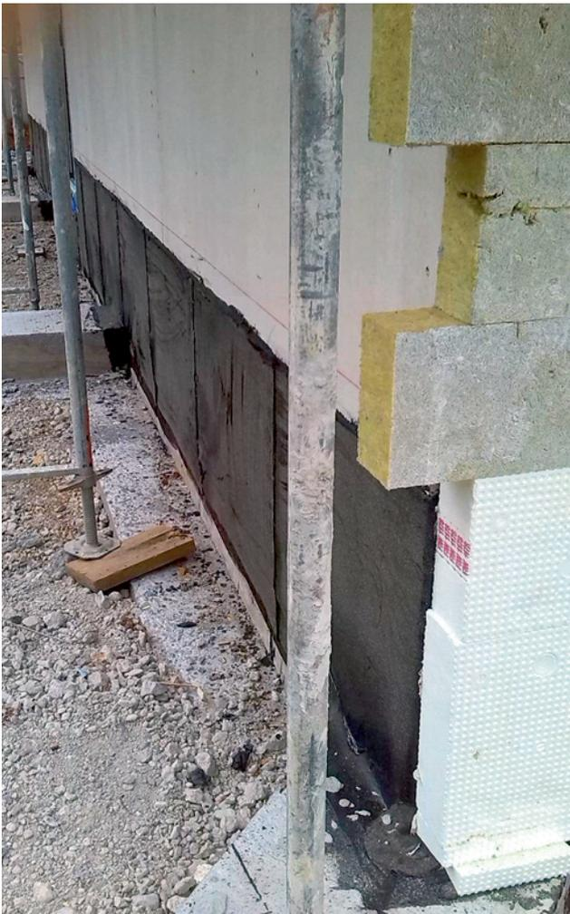
1 | Sockelabdichtung mittels Voranstrich und Bitumenbahn
