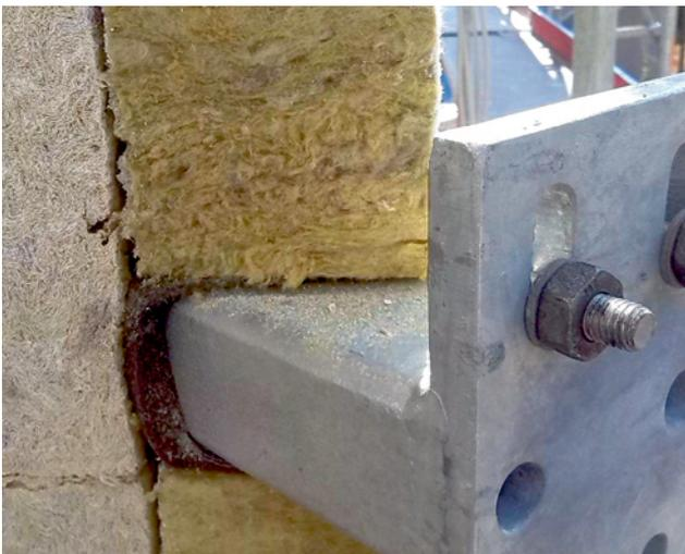
6 | Umschließen von Einbauteilen mit Kompriband, auf wirkliche Kompression beim Kompriband achten!
