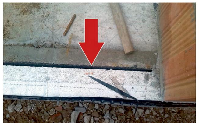
4 | Die hervorgehobene Fuge muss kraftschlüssig verdübelt werden.
